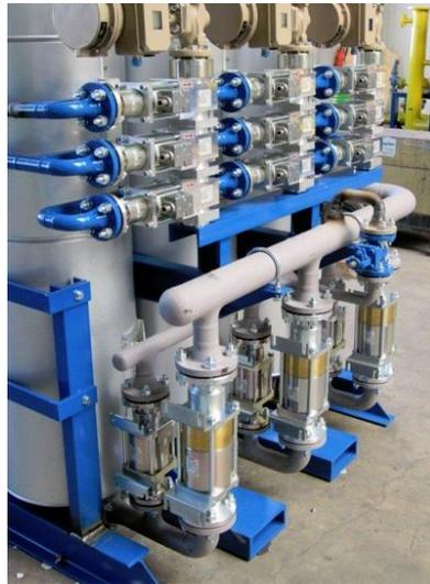
BU: coax® Ventile integriert in ein Durchflussregelungssystem
